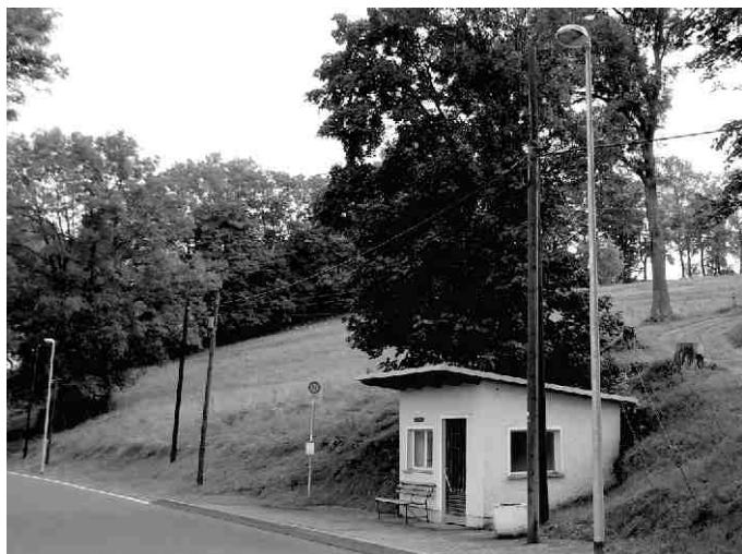
Neue Straßenlichtmasten an der Bushaltestelle Gasthof Weißbach, Freiburger Straße
