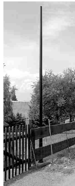
Neuer Straßenlichtmast am Fußweg zur Oberschule, die Leuchte wird noch angebaut
