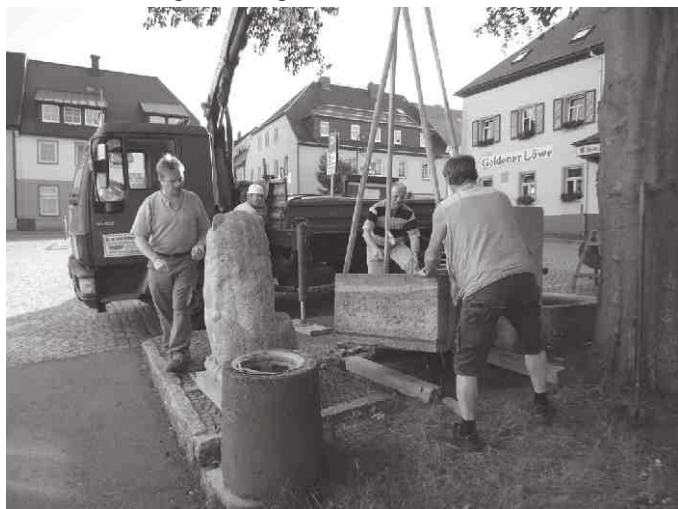
Die Firma G. + S. Richter GbR und Mitarbeiter des Bauhofes bei der Demontage des Rathausbrunnens
