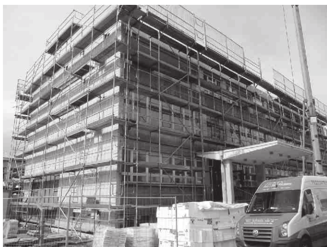
Foto: Die Bauarbeiten sind in den Schulferien im vollen Gange.
