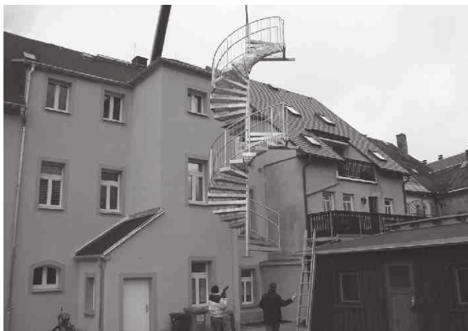
Foto: Einbau der Rettungstreppe Haus 2 der Grundschule
