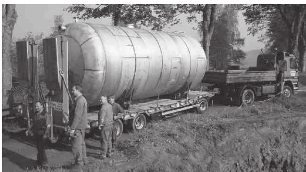
Foto: Maßnahme Bau unterirdischer Löschwasser- behälter am Pflegeheim "Am Wallgraben"
